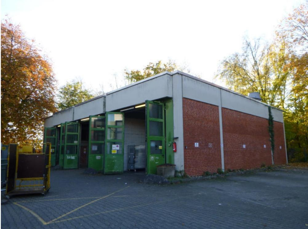
**Foto 5:** Das Gebäude 6 ist ebenfalls mit einer Attikaverkleidung versehen.
