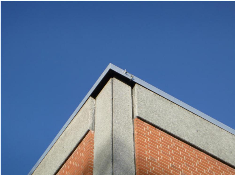
**Foto 4:** Hier eine Detailansicht, die den Spalt hinter dem Blech zeigt.
