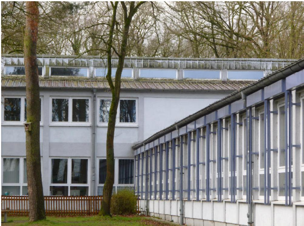
**Foto 12: Ein- und zweigeschossige Gebäudeteile. Gut zu erkennen sind die nachträglich angebrachten Sonnenschutzlamellen an dem eingeschossigen Trakt, wo Klassenzimmer untergebracht sind. Blickrichtung Südwest.**
