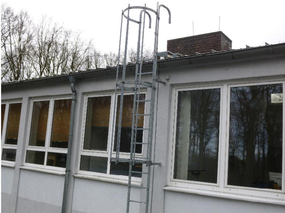
**Foto 4: Zweigeschossiger Gebäudetrakt mit Feuerleiter und einer dahinter liegenden Dehnungsfuge.**
