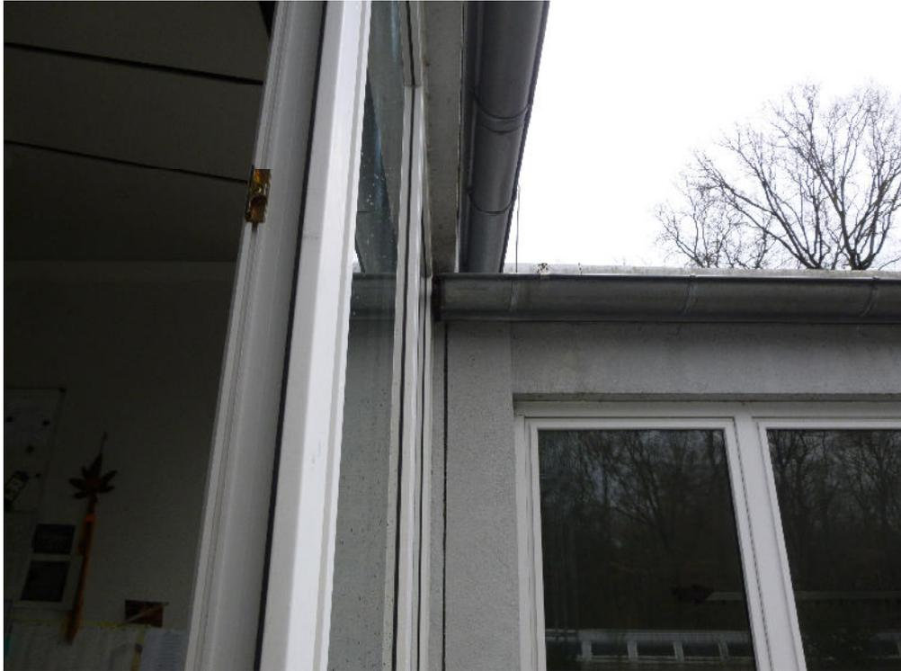
**Foto 5: Dehnungsfuge in Gebäudenische am Übergang von einem zum anderen Gebäudetrakt.**
