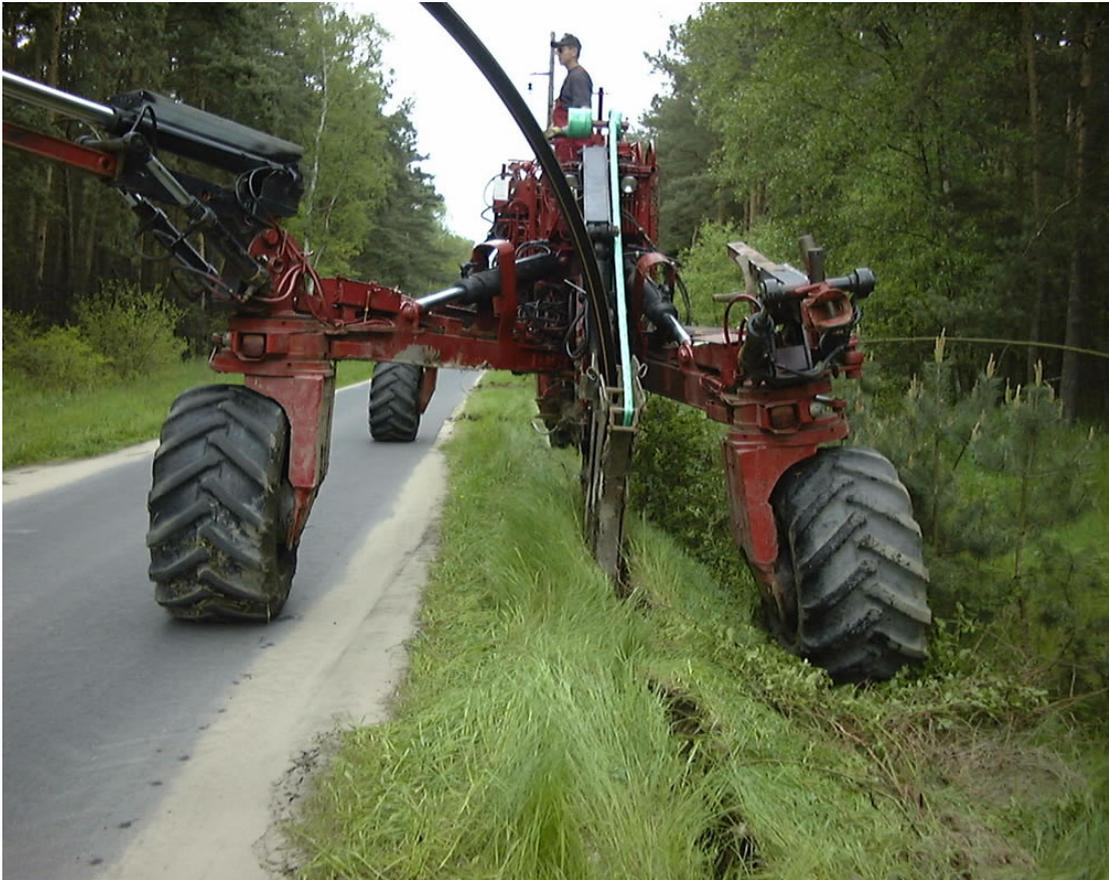
Abbildung 2.4: Foto einer Kabelverlegung mit dem Verlegepflug (FIRMA FÖCKERSPERGER 2015)
