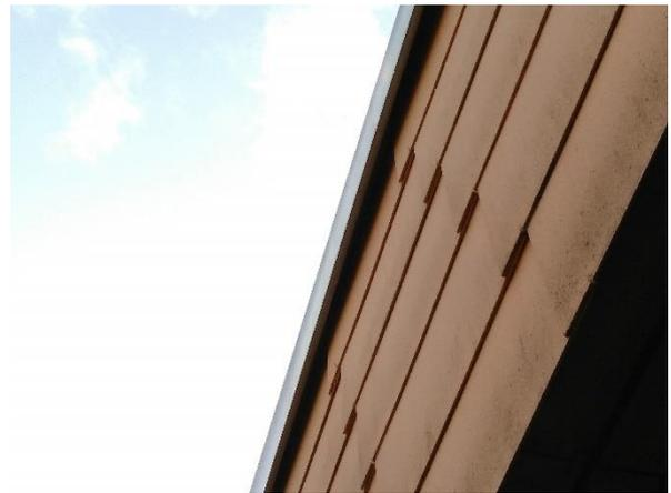
Abb. 4: Spalt zwischen Dachverkleidung und Fassade
