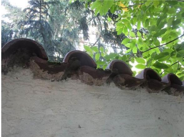
Abb. 22: Hohlräume bei Dachziegeln
