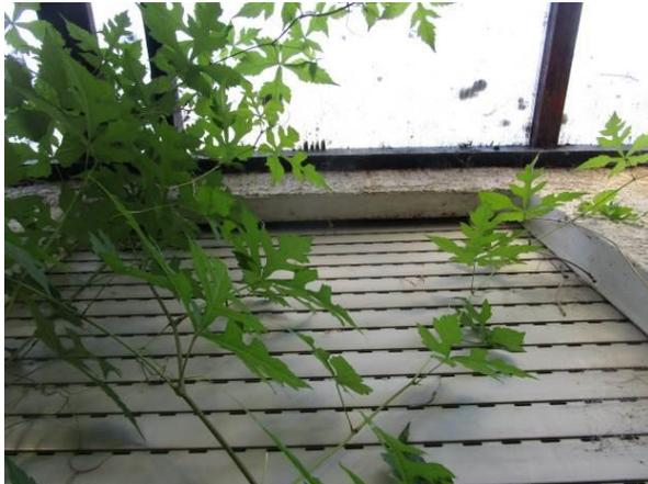
Abb. 25: Spalte am Rollladen
