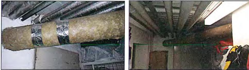
Turnhallenanbau „Süd“ : KMF als Dämmungen um Rohrleitungen
