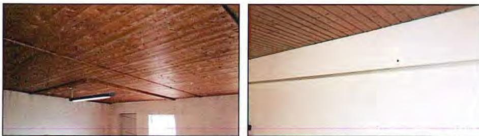
Turnhallenanbauten „Nord“ und „Ost“: KMF als Auflagen in Abhangdecke und hinter Verkleidungen von Lüftungskanälen
