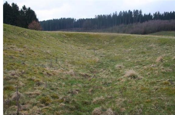
Bild 17: künstlich angelegtes Regenrückhaltebecken
