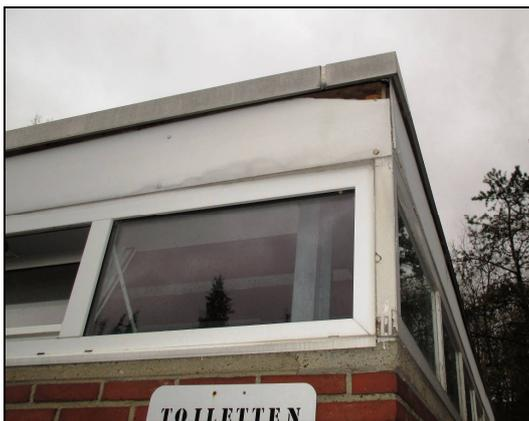
**Bild 13:** Schaden an der Dachkante eines Umkleidegebäudes.
