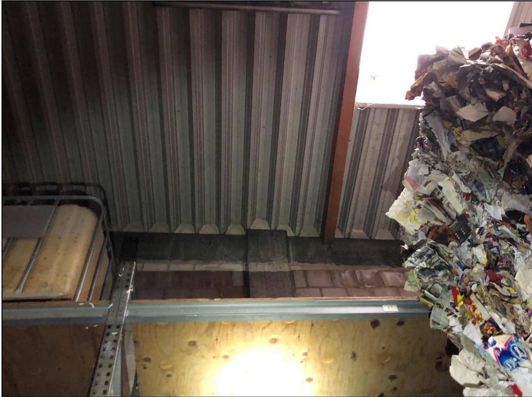
**Abbildung 20: Beispiel für die Verfung im Dachübergangsbereich (hier: Gebäude 12)**
