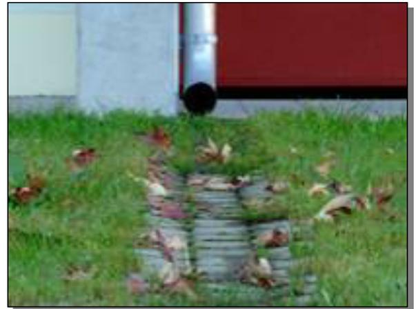
Regelung zur Regenwassereinleitung der Dachflächen (Haus und Garagendach) in die Transportmulde. Regenwasser der Zufahrten sind in den Mischwasserkanal einzuleiten.
