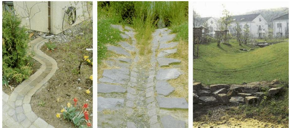
Abbildung 29: Beispiele für die Anlage von Transportmulden in den Gartenbereichen (Bilder links) sowie für eine Versickerungsmulde im öffentlichen Grünraum
