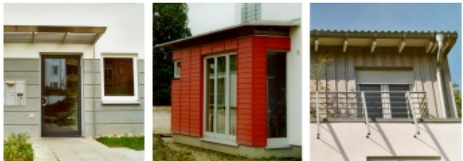
Abbildung 14: Beispiele für Materialkombinationen im Sockelbereich, für vorspringende Bauteile sowie für das Staffelgeschoss
