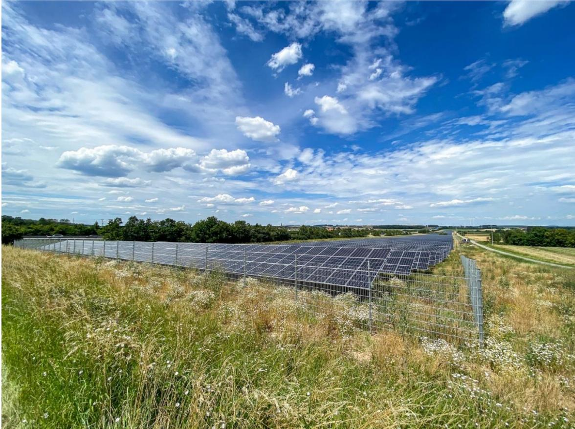
Abbildung 12: Beispiel Einfriedung einer PV-FFA (Foto: EE-Plan, April 2020)
