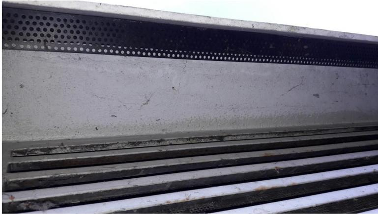
Foto 11: Die Spalten an der Attika der Flachdachgebäude C, D, L, M und N waren überwiegend mit Gittern verschlossen. Hier: Gebäude L.
