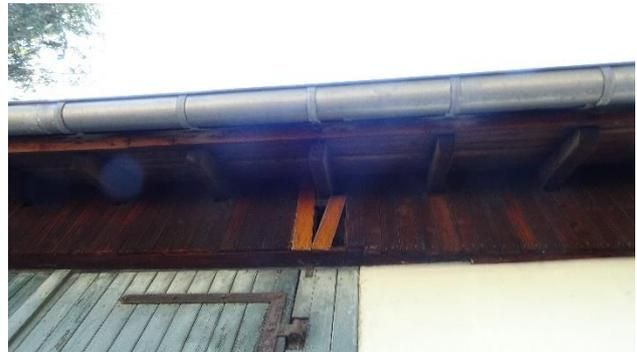
Abb. 18: Dachbereich aus Holz mit Einflugloch (ISR 2022)
