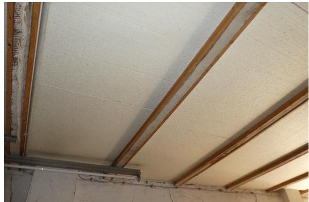
Foto 40: ... oder Isolierung mit Styropor
