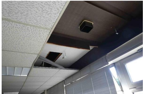
Foto 25: Holzverkleidung hinter Deckenabdeckung, Fenster geöffnet
