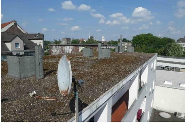
Foto 44: mit Kies belegtes Dach
