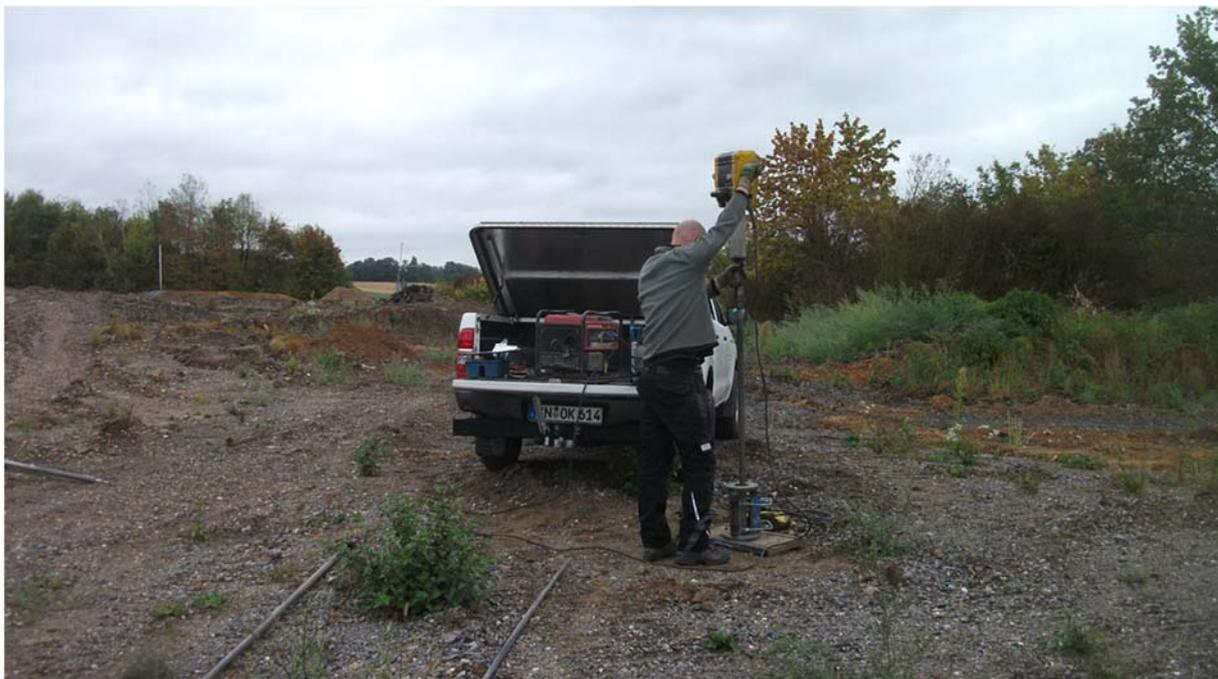
Abb. 5.4.1: Beispiel für die Durchführung einer Rammkernsondierung (RKS).
