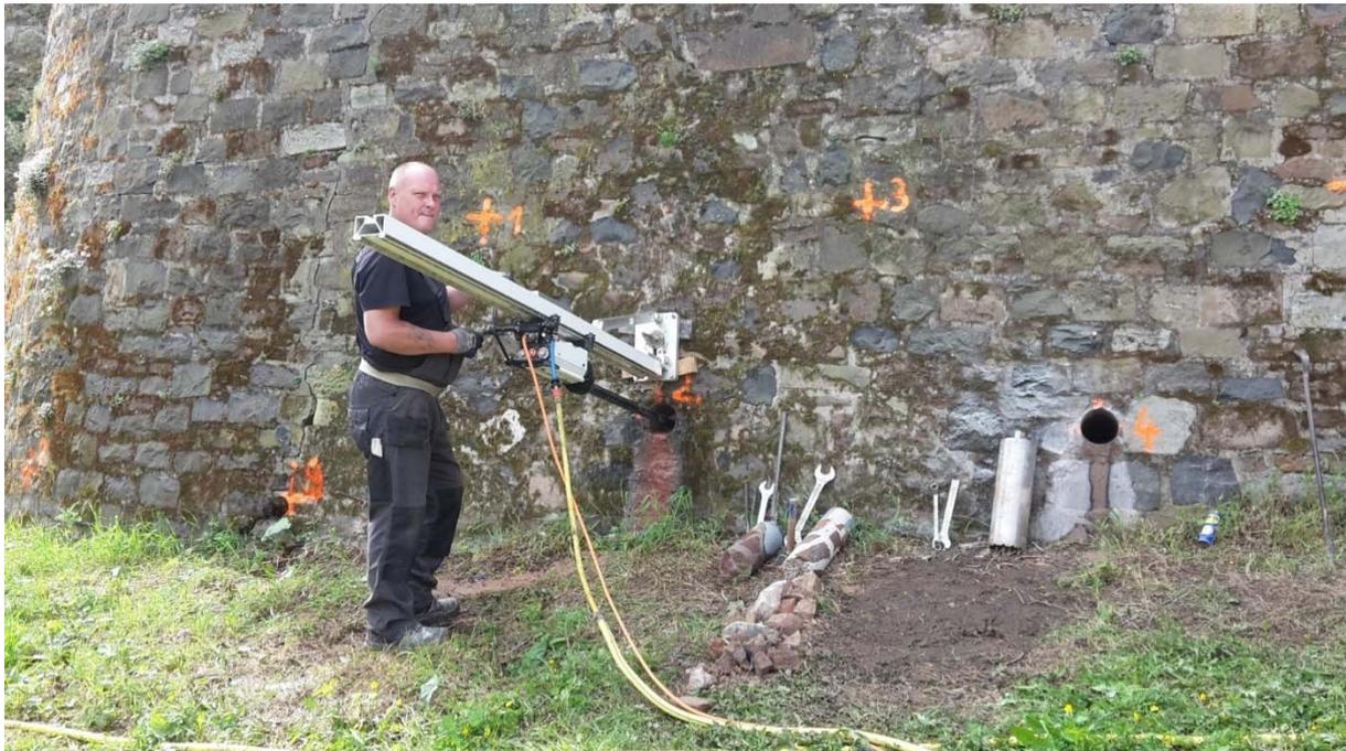
Abb. 5.5.1.b: Beispielbild zum Kernbohrverfahren mittels Diamant-Hohlbohrkrone und Bohrlafette.
