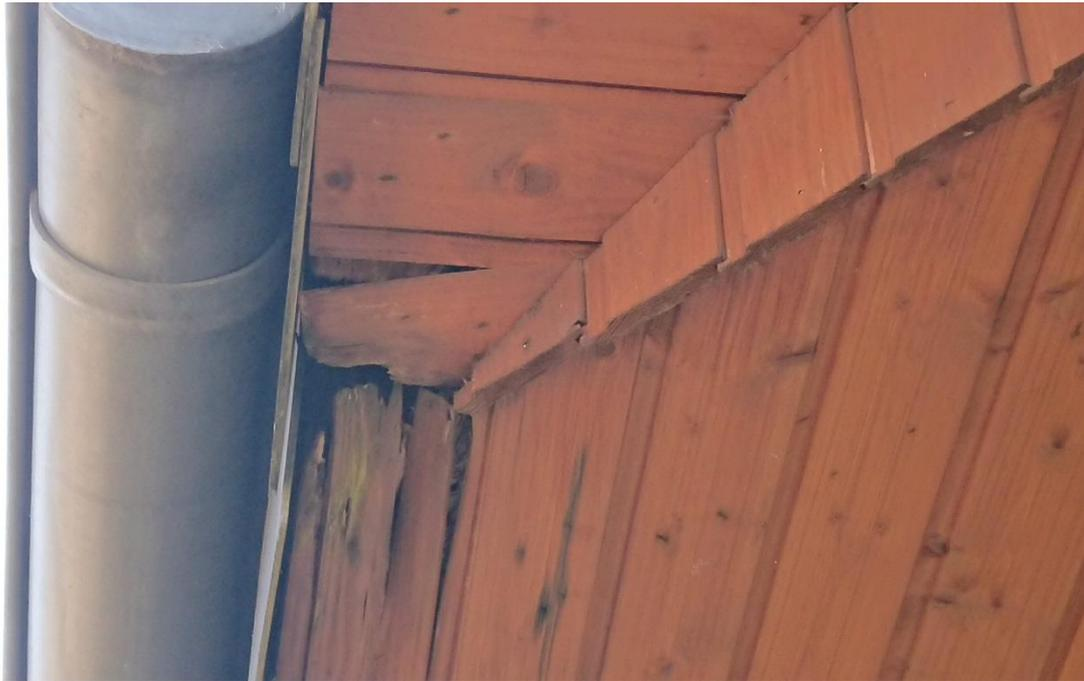
**Foto 3 beschädigter Dachüberstand**
