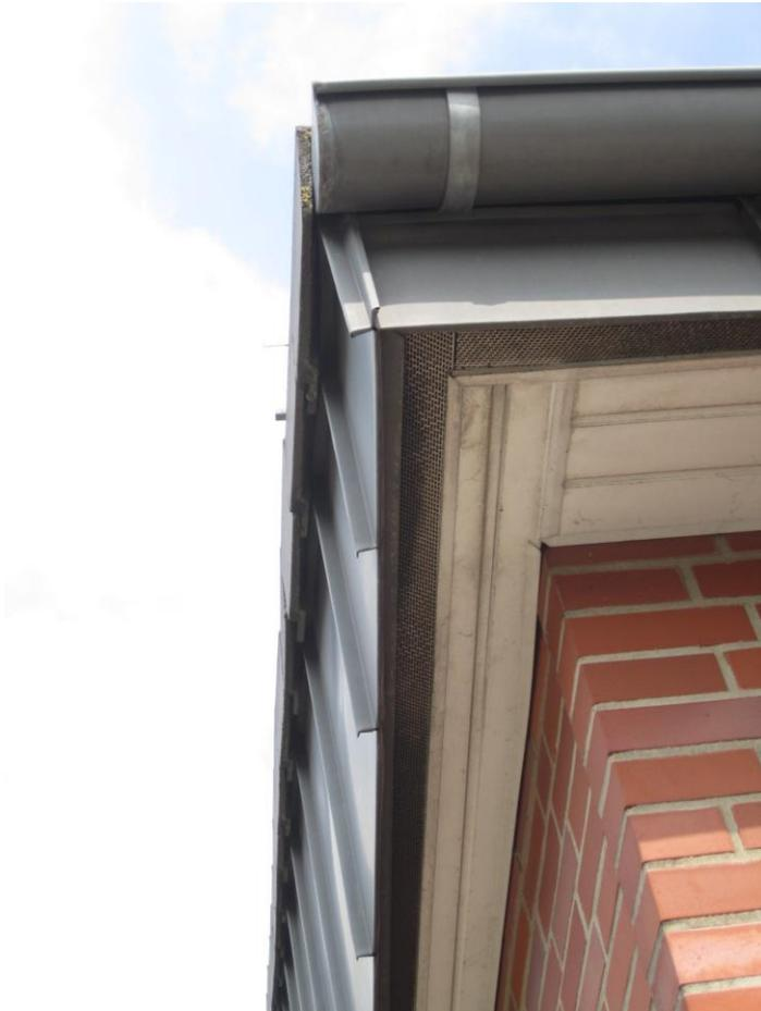
**Foto 4: Blick hinter die Dachverkleidung (vergitterte Spalten)**
