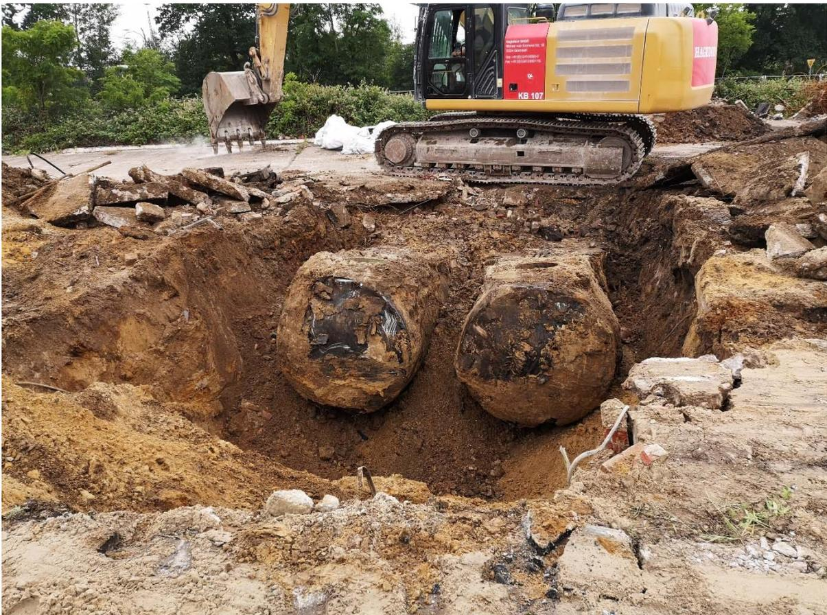
*Bild 3: Unterirdische Tanks im Bereich der ehem. Betriebstankstelle, 11.06.2019*
