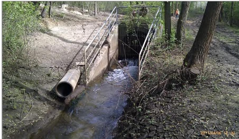
Abb. 11: vorhandene Einleitung DN 2000 (Kraftwerk) und neue Einleitung DN 400 aus F23
