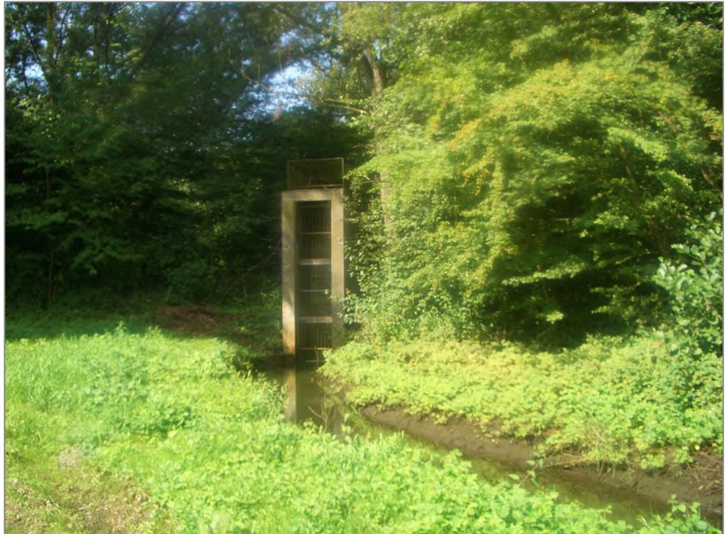
Abb. 6: Drosselbauwerk mit Abflussblende im unteren Bereich und obiger Überlaufschwelle
