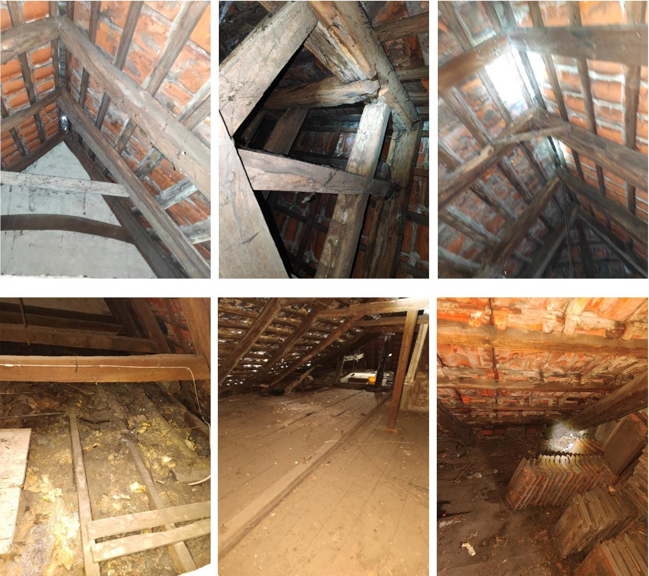
Fotos Dachboden mit zahlreichen Marderspuren, rechts unten Dohlennest im Eckbereich
