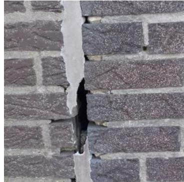
Abbildung 15: Spalten im Mauerwerk.
