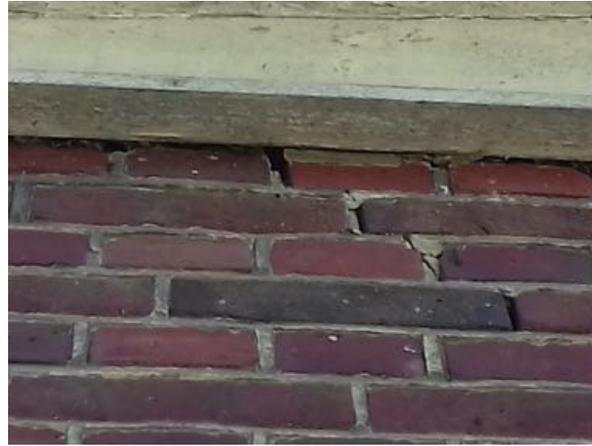
Abbildung 7: Beschädigte Stellen im Mauerwerk.
