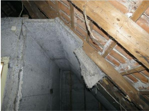
Abbildung 6: Dachstuhl gedämmt/ungedämmt.
