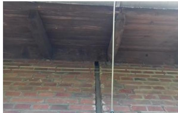
Abbildung 13: Große Öffnung im Mauerwerk.
