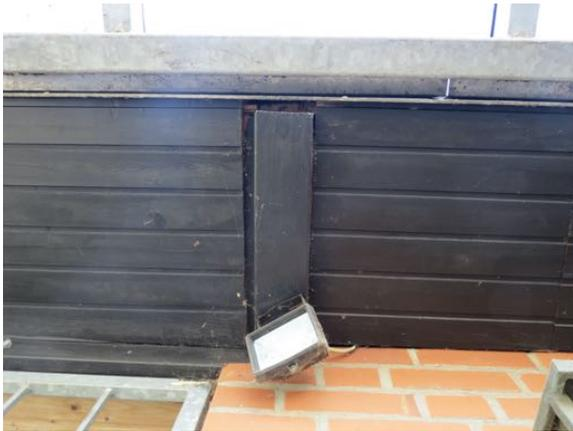
Abbildung 2: Spalten im Hohlkasten.
