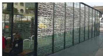
Siebdruck ist haltbarer als Folien und kann auch außen (Ebene 1) angebracht werden.
