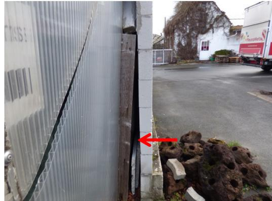
Abb. 24 Zwischenraum zwischen Mauerwerk
