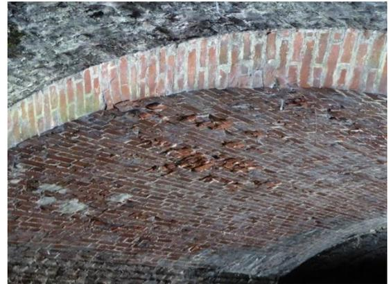
**Abbildung 11:** Rissige Wand- und Deckenstrukturen im Durchlass
