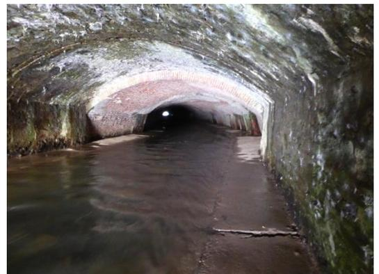
**Abbildung 6:** Gewölbeoberbau aus Ziegeln im Innern des Durchlasses
