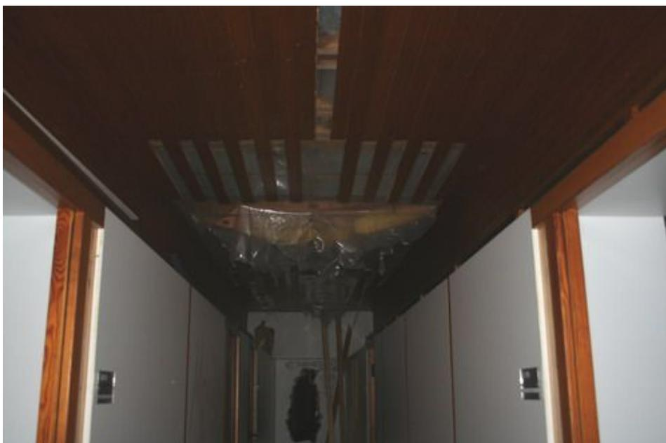
*Foto 5: Vandalismusschäden – Aufgerissene Deckenkonstruktion in einem ehem. Verwaltungsgebäude.*
