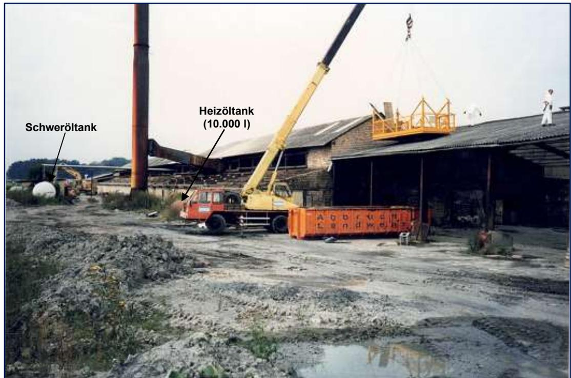
**Abb. 8: Abbruch der Produktionshallen im Jahr 1995 und Lage des Heizöltanks (10.000 l) sowie des Schweröltanks**
