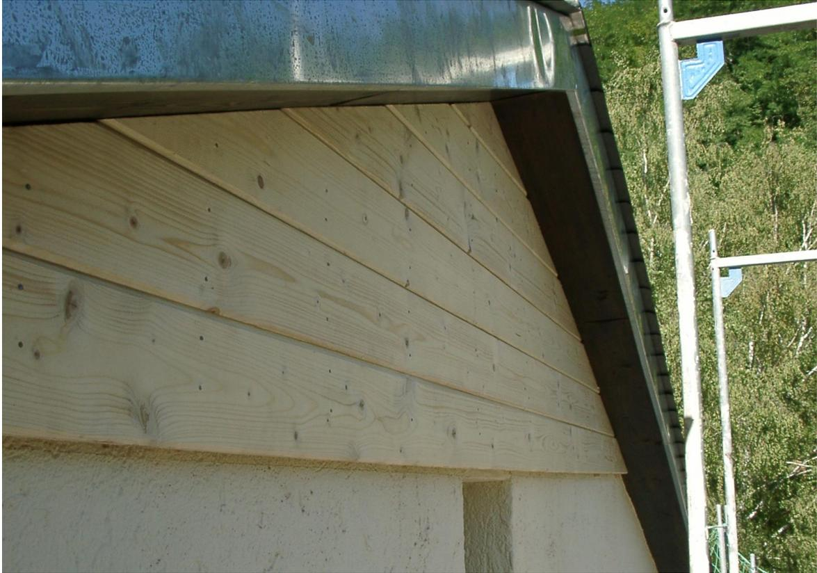
Abb. 26: Hier mit Nut-Federbrettern verschalt, die Einflüge befinden sich unter dem Abschlussbrett, von wo aus die Fledermäuse hinter die Verschalung gelangen.
