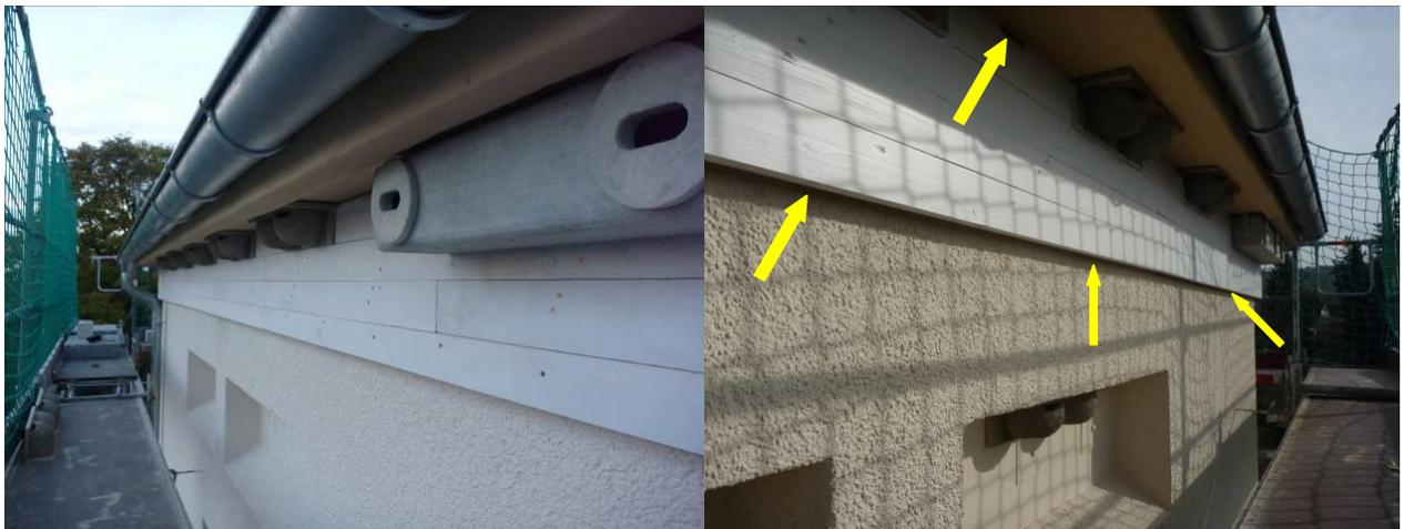
Abb. 29+30: Finale Version, die Pfeile zeigen die Ein- bzw. Ausflugmöglichkeiten an, hier an einem ehemaligen Trafoturm mit weiteren Maßnahmen für Mehlschwalben und Mauersegler.
