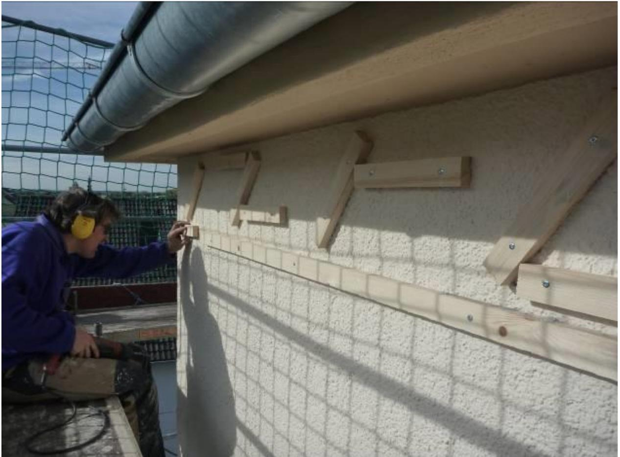
Abb. 28: Ähnliches Prinzip der Lattenkonstruktion jedoch mit waagerechtem Abschlussbrett. Öffnungen sind dann im Abstand von 1-2m anzubringen oder im Bereich der Traufkante
