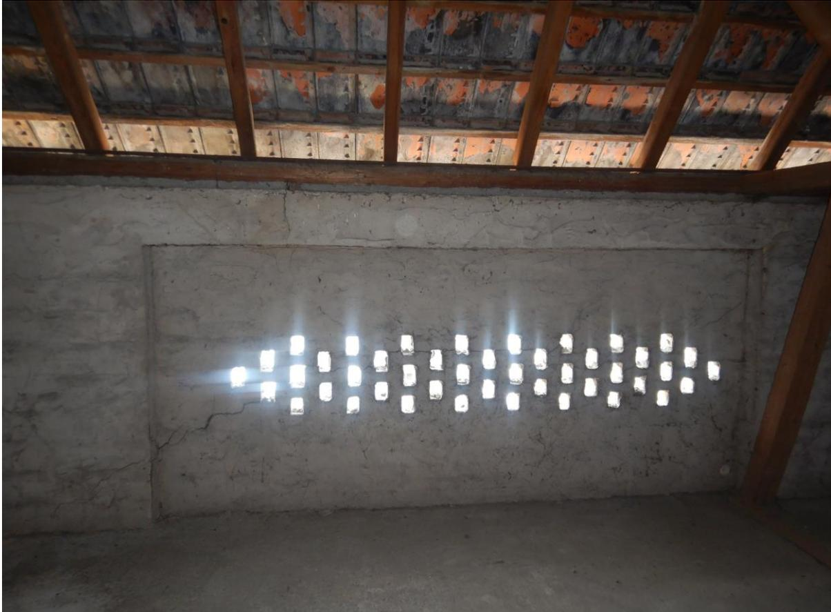
Abb. 19: Auch die Einflugmöglichkeiten am Trauf und an den Seiten im Mauerwerk werden für die Fledermäuse günstiger durch schlitzförmige Öffnungen gestaltet.
