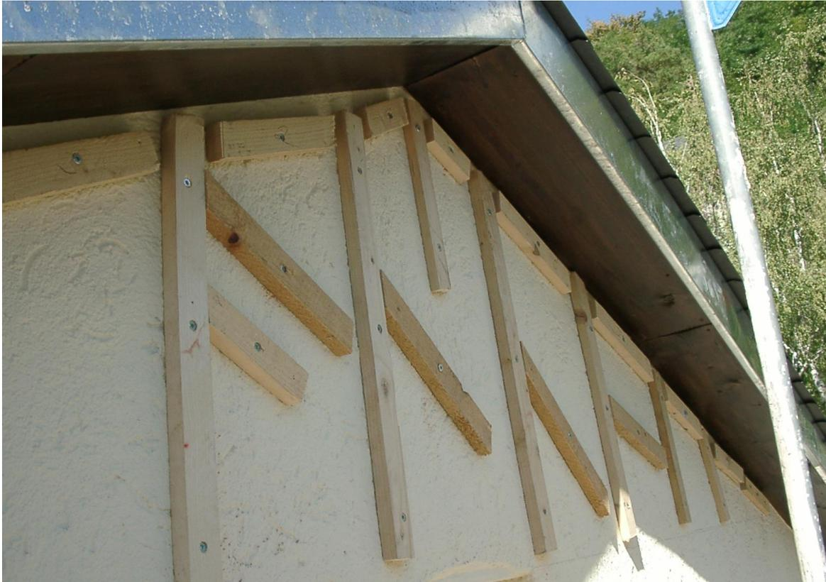
Abb. 24: Nut-Federverschalung mit spezifischer Lattenkonstruktion hergestellt, so dass die Muttertiere ihre Jungtiere auf den leicht schräg verlaufenden Dachlatten ablegen können, nicht aber sich Kot ansammeln kann. Quartiertyp an den Giebelseiten der Scheune.
