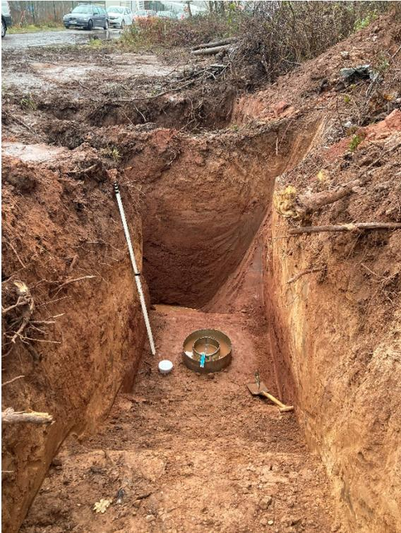
**Bild 3: Schurf 2 mit Versickerungsversuch VV 1**
