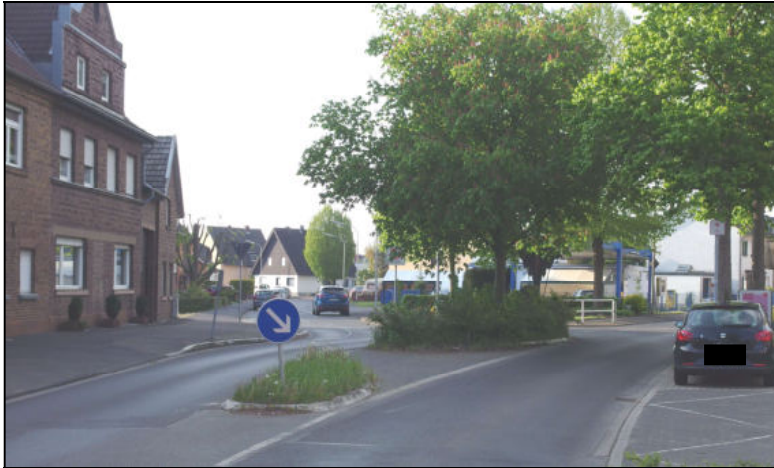
Bild 7: Knotenpunkt Bonnstraße / Lindenstraße mit Querungshilfe und Bepflanzung
