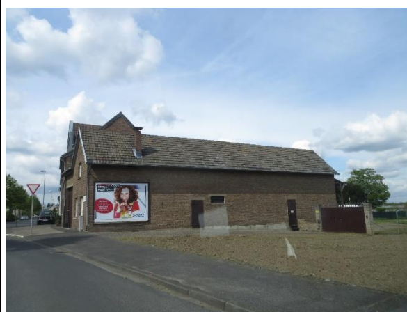
Blick auf Teil der betroffenen Gebäude
