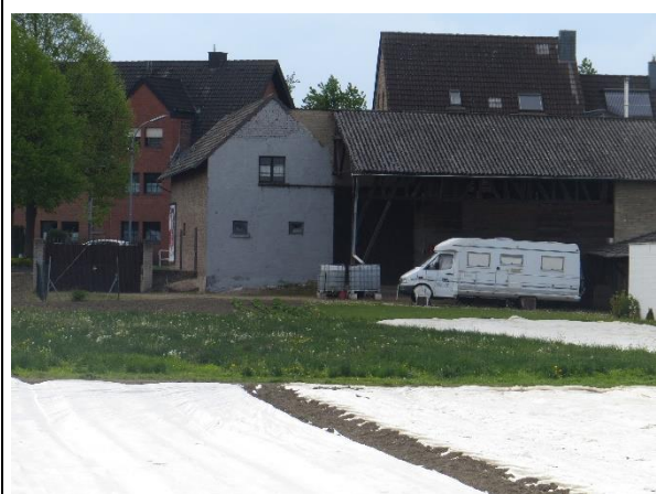
Blick auf Teil der betroffenen Gebäude
