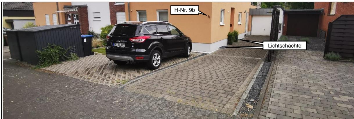
Abbildung 26: Grundstück der Kuhgasse 9b mit Gefälle in Richtung der Lichtschächte
