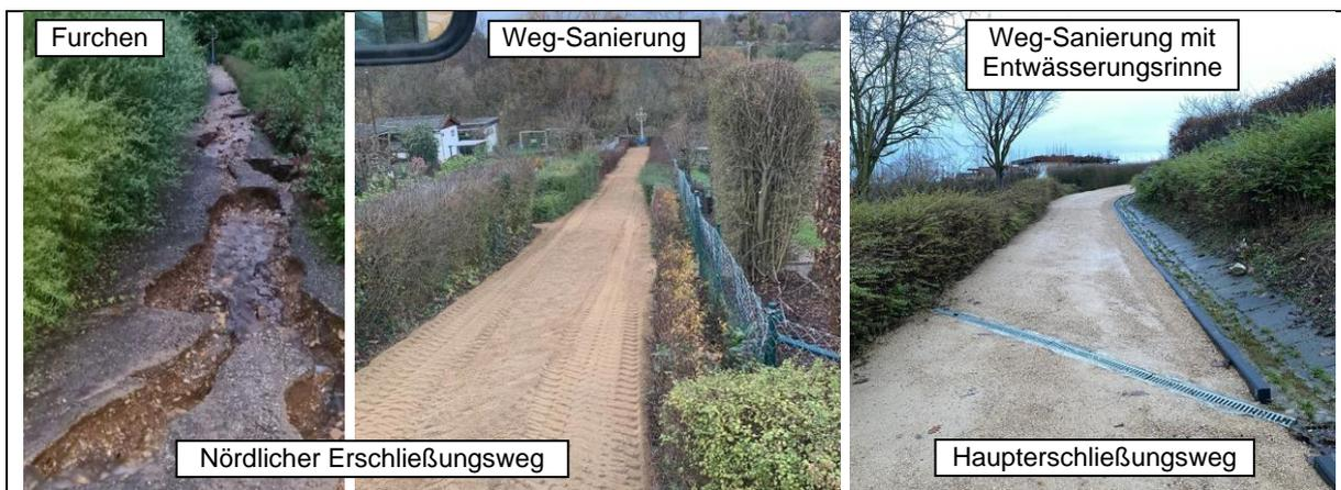
**Abbildung 28: Schäden und anschließende Sanierungsmaßnahmen innerhalb der Wege der Kleingartenanlage**
