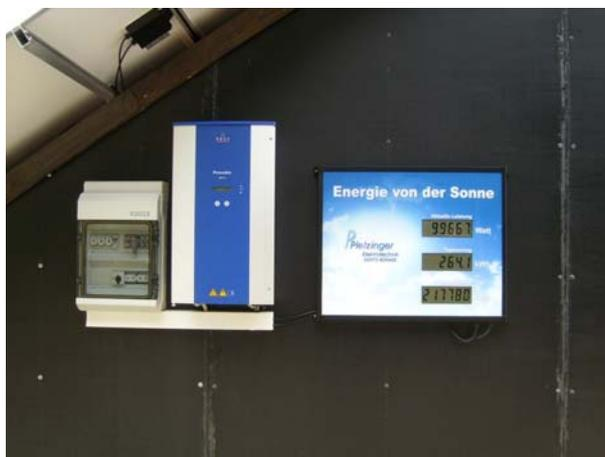
**Abb. 3: Blick auf die an den Holzschuppen angebrachten Messgeräte, die den erzeugten Solarstrom messen. Foto: K.-H. Loske, 19.8.07.**
