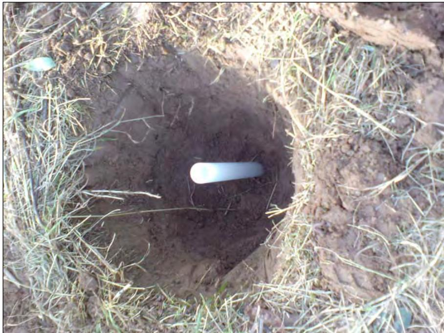
Bild 1: Aufsatzrohr / Filterrohr aus PE im Bohrloch
