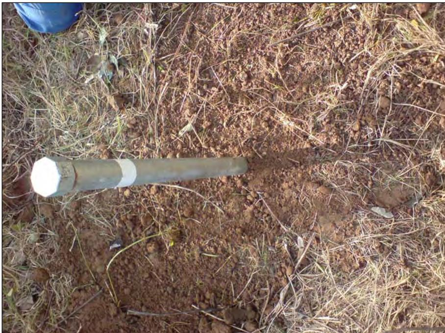
Bild 6: Pegel fertig gestellt, Boden aufgefüllt. Aufsatzrohr mit Verschlusskappe
