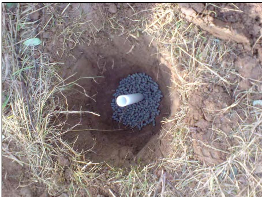
Bild 2: Dichtung aus Quellton
