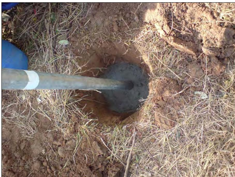
Bild 4: Stahl-Aufsatzrohr wurde über PE-Rohr geschoben
