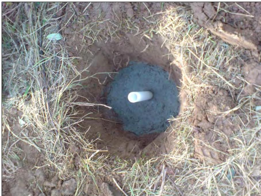
Bild 3: Eingebrachte Zementpackung (1)
