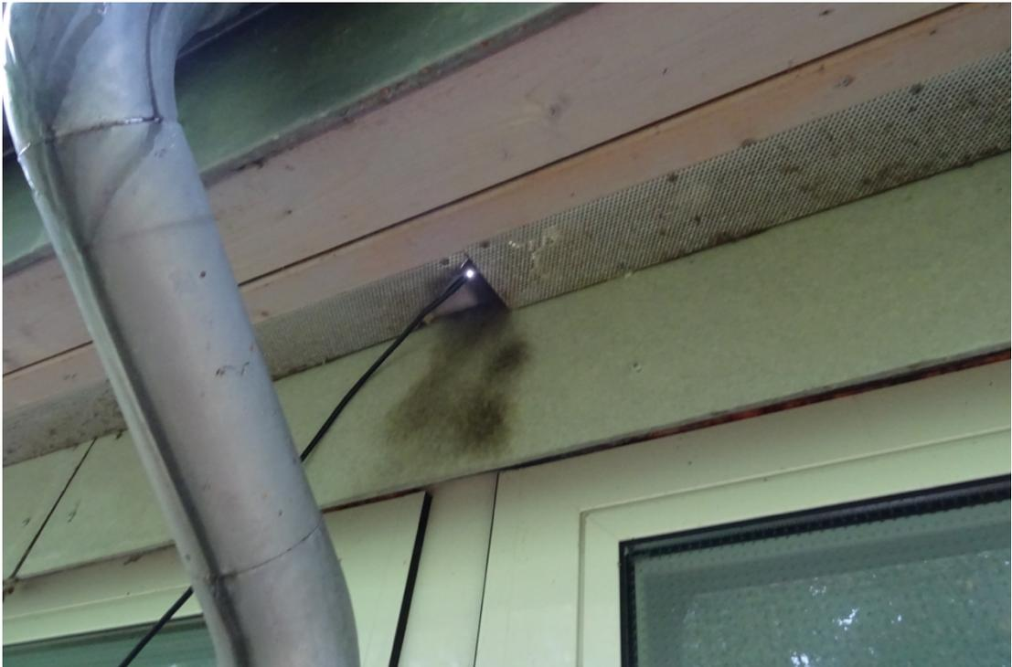
**Abbildung 7** Untersuchung einer möglichen Einstiegsstelle eines Marders an der südlichen Gebäudefassade
