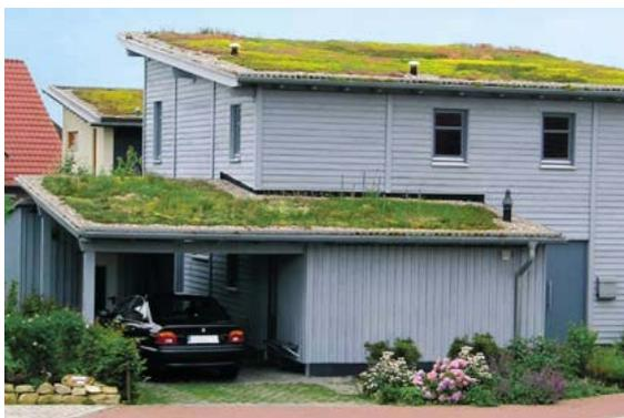
Zur Reduzierung der Spitzenabflüsse von Niederschlagswasser ist ferner im B-Plan Nr. I/St 50 eine extensive Dachbegrünung für Flachdächer festgesetzt. Dies bietet sich z. B. bei Garagen und Carports an.
