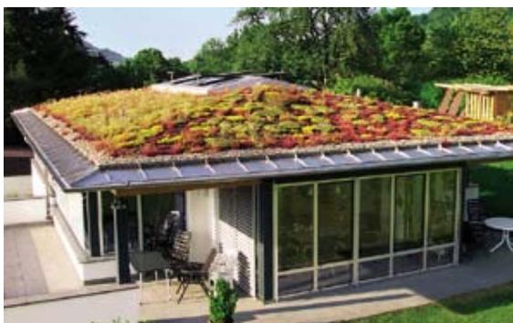
Im Vergleich zu einem trockenen Ziegeldach werden bei einem trockenen Gründach die Abflussbeiwerte auf ca. 1/5 verringert. Selbst bei wassergesättigter Dachbegrünung werden Abflussspitzen noch deutlich verzögert.
