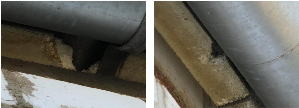
Abbildung 21a/b: Löcher in Dachdämmung mit Kratzspuren.
