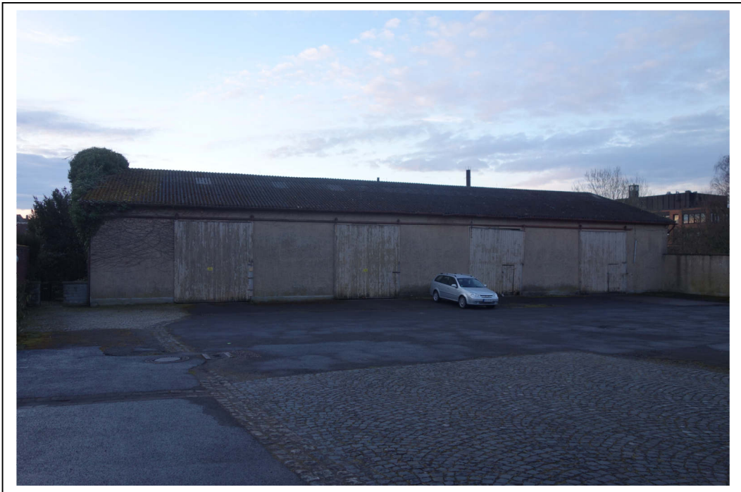
Foto 2: Lagerhalle im hinteren Bereich der Parzelle.
