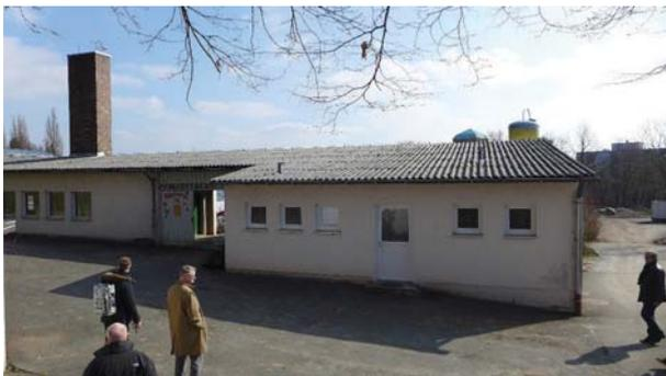
Bild 4: Überblick Komplexe 1 und 2, links Schornstein, Dacheindeckung mit Wellasbestplatten)
