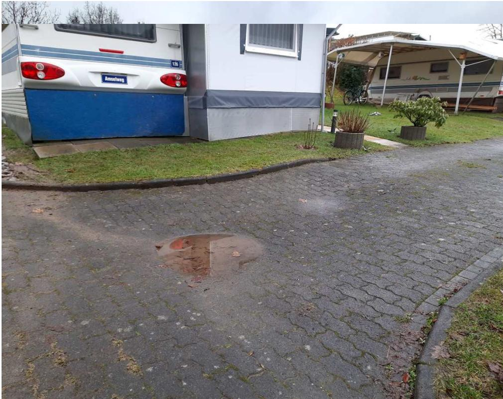
Abbildung 2: Wegschäden im Bereich des Deponiekörpers auf dem Campingplatz (03.02.2022)
