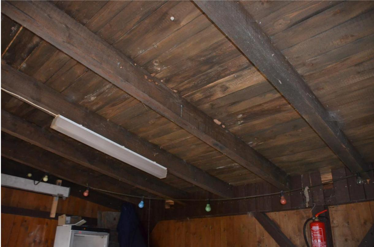
**Abb. 3: Dach von Innen. Unter den Holzbrettern befindet sich eine Spahnholzplatte ohne dazwischen liegende Nischen oder Hohlräume.**
