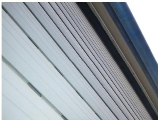
**Abb. 8** Spalten im Rollladenkasten an der Westseite des Gebäudes 18c.
