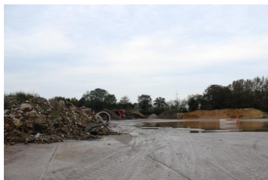
Westlicher Teil / Bauschuttrecyclinganlage
