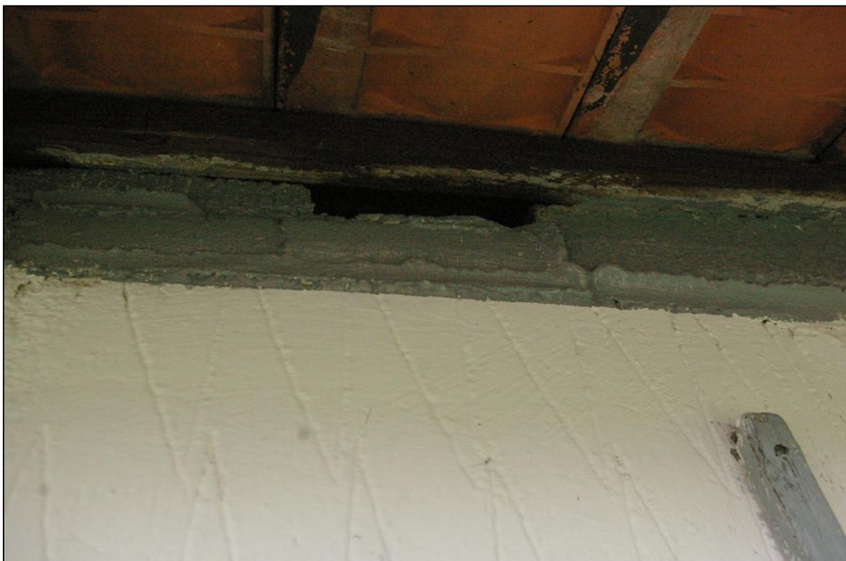
Abbildung 10: Fehlender Ziegelstein unter dem Dachvorsprung des Gartenhäuschens
