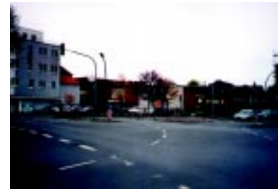
Überdimensionierte Verkehrsflächen am Neutor (oben) und wenig attraktive Tiefgaragenzufahrt am Roggenmarkt (unten)
