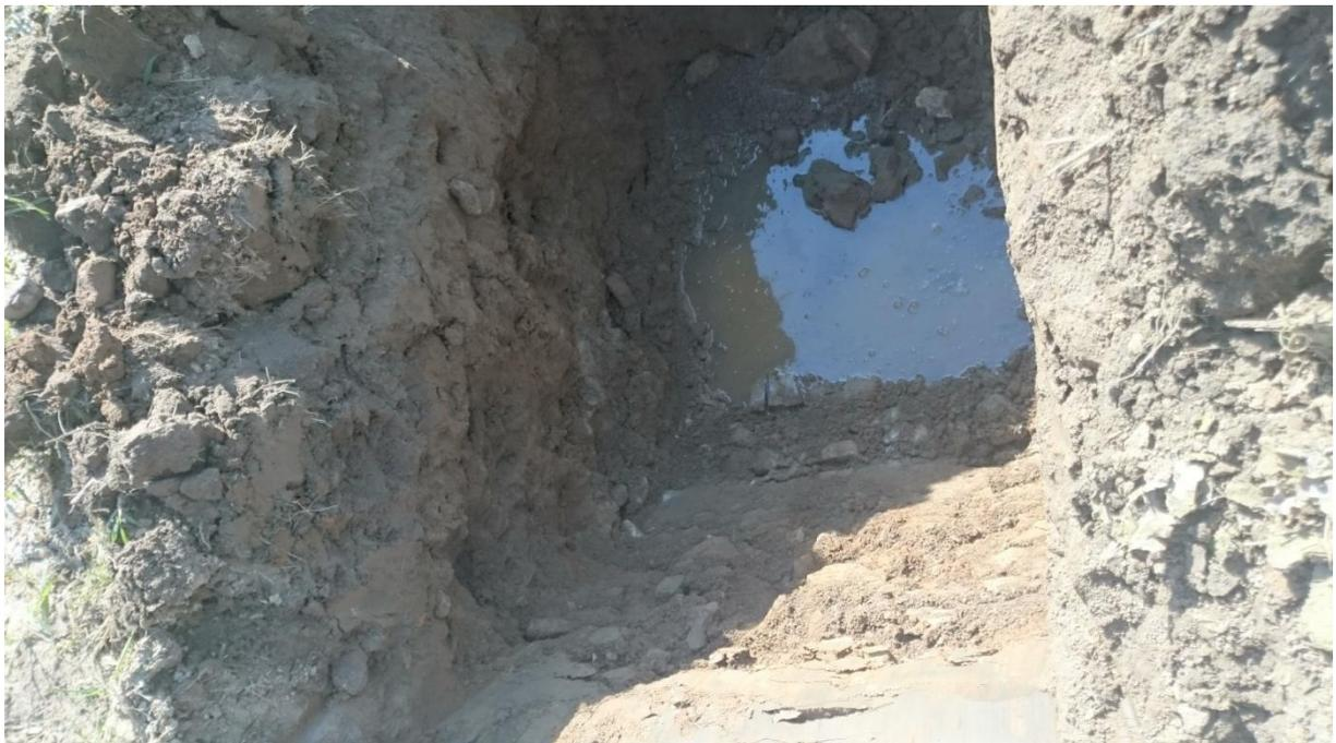
**Abb. 3:** Blick in Schurf 1. Hier hat sich nach etwa 15 Minuten 0,05 m Grundwasser eingestellt. Ein weiterer Anstieg wurde nicht festgestellt.
