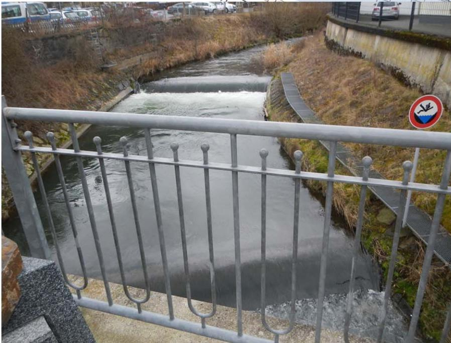
In den 1980er Jahren stark technisch orientiert geplant, stellen die Betonschwellen in der Röhre oberhalb der Postbrücke ein Hindernis für Fischwanderungen im Flusslauf der Röhre dar. Dieser Zustand widerspricht den Zielvorgaben der Europäischen Wasserrahmenrichtlinie. Ein bedeutendes Teilprojekt bildet daher die Umgestaltung beider Bauwerke.
