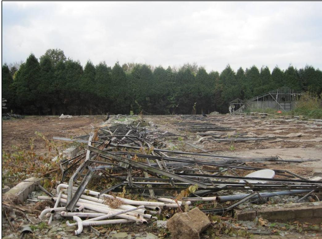
**Abb. 3:** Die Gewächshäuser wurden bereits abgebrochen. Bauschutt ist noch auf der Fläche vorhanden (Aufnahme vom 26.10.2017). Der hohe Versiegelungsgrad der Fläche ist ebenfalls erkennbar.
